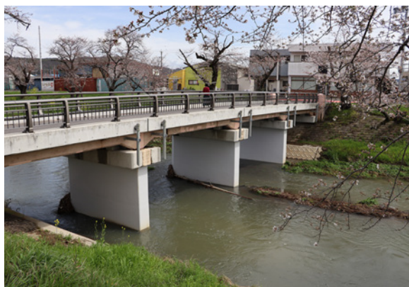
計画に基づき耐震対策が進む橋
