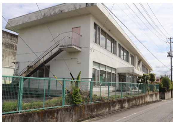
解体後は駐車場利用を予定している鵜沼中保育所
