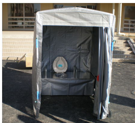
災害時の活用が期待されるマンホールトイレ
