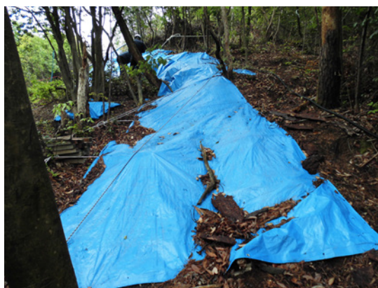
崩落防止工事を行う大塚山緑地（新鵜沼台7丁目付近）
