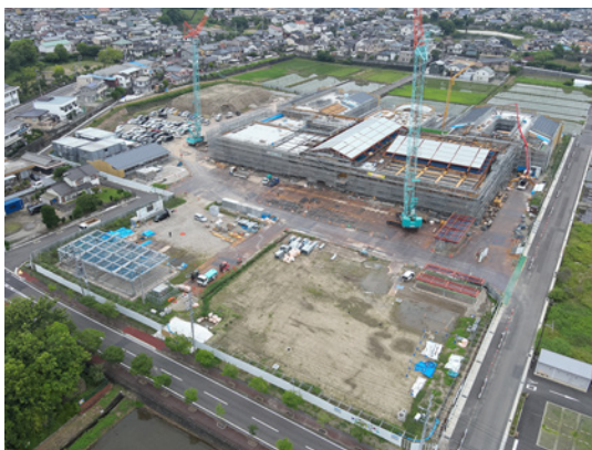
開校に向け工事が進む新特別支援学校
