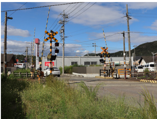
踏切拡幅により安全・安心な道へ
