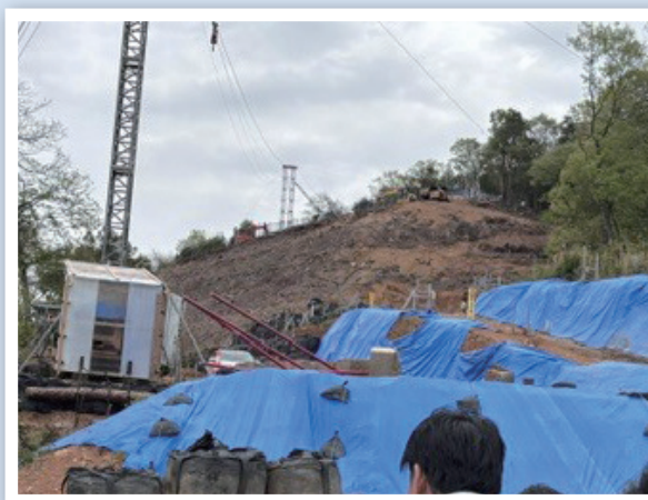
施工が進むのり面対策工事の現場
