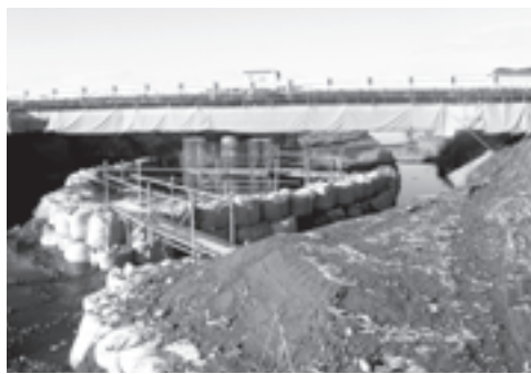
現在修繕中の同島橋（蘇原宮塚町）
