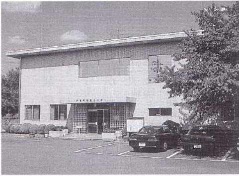
川島地区の健康福祉の中核施設となる現川島町保健センター
