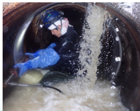
【下水道の耐震化工事の様子】
