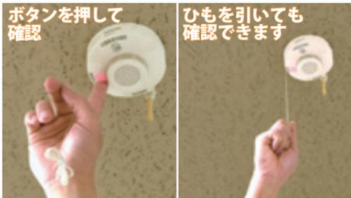
作動確認しても、警報器に反応がなければ、本体の故障か電池切れです。警報器の本体または電池を交換しましょう
