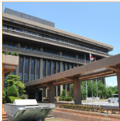
昭和 48 年竣工の現市役所本庁舎
