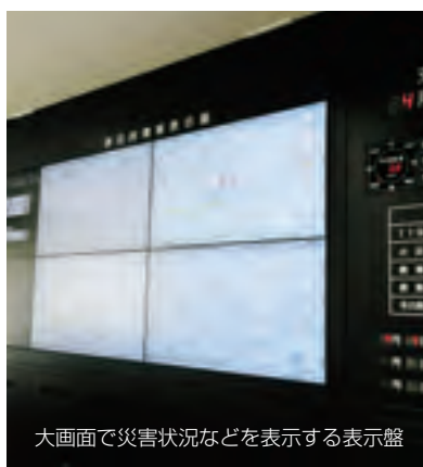
指令センターの制御装置
