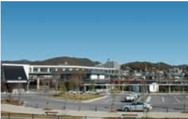
新鷺沼駅前広場・鷺沼空中歩道完成 市の東の玄関口、都市拠点として新鷺沼駅周辺が生まれ変わりました。
