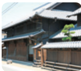
▲旧旅籠を改修した中平一山道鵜沼宿町屋館。オープンした建物です。
