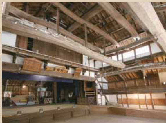
▲修理完成が待ち遠しい村国座の様子
