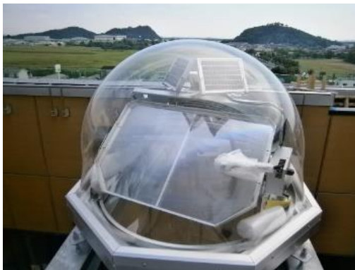
（左：太陽光採光装置、右：太陽光パネル）
