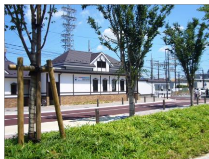
● 景観に配慮した公益施設（各務原市役所前駅）
