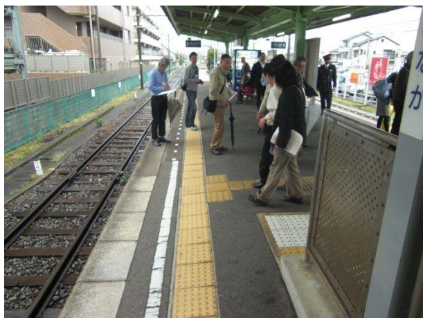
ホームの点字ブロック
