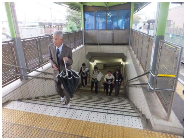
階段の手すりと点字ブロック
