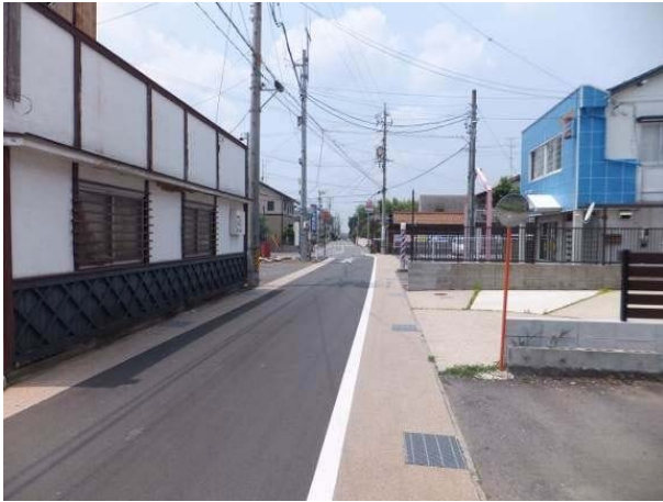
カラー舗装によるソフト分離
