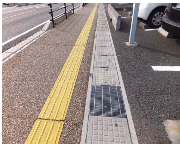
側溝、グレーチングの改修
