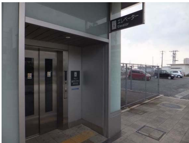
エレベーターの設置
