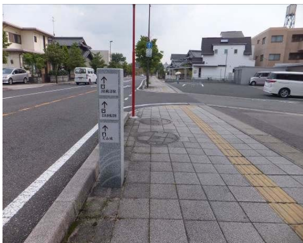
視覚障がい者誘導用ブロックの敷設
