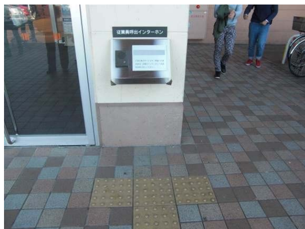
出入口のインターホン設置
