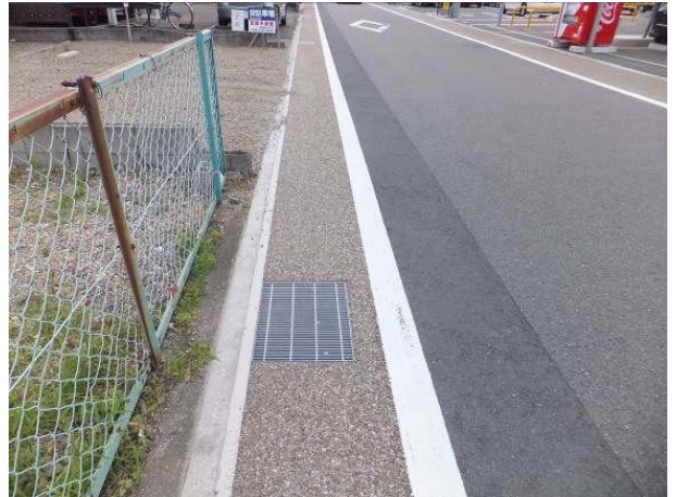
側溝、グレーチングの改修
