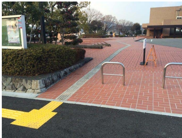
前面道路から出入口までの 視覚障がい者誘導用ブロックの敷設
