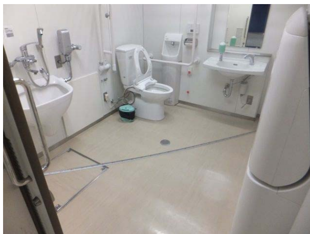
多機能トイレの設置
