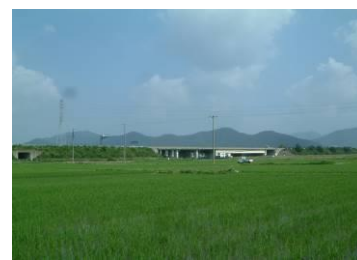
地域の境となる東海北陸自動車道
