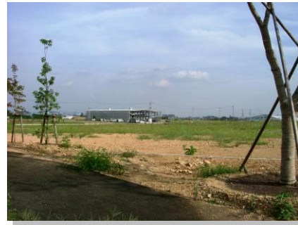
新たな工業団地のための大規模な造成 (那加山崎町)
