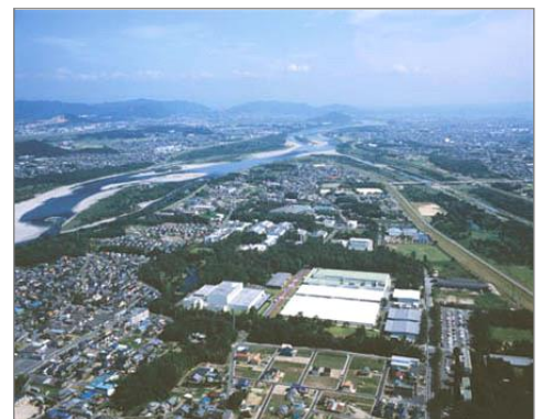
川島工園全景
