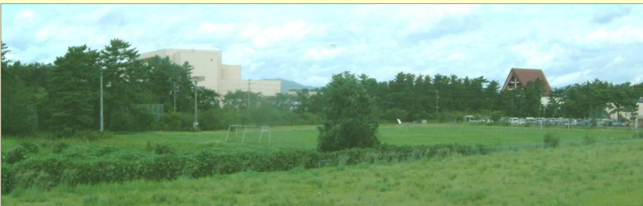
▲ 堤防道路から川島工園を望む
