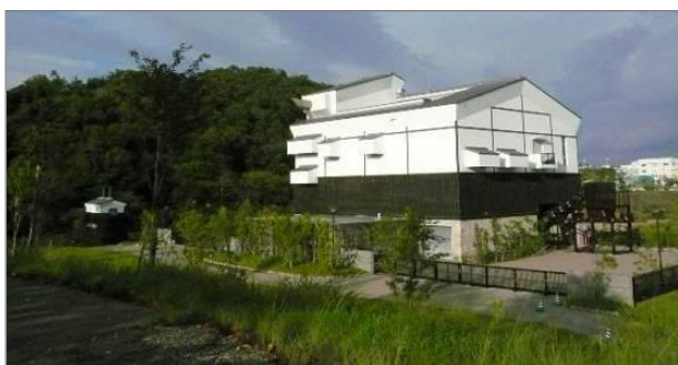
上戸排水機場
