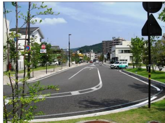
電線類が地中化された鶺沼駅前通り
