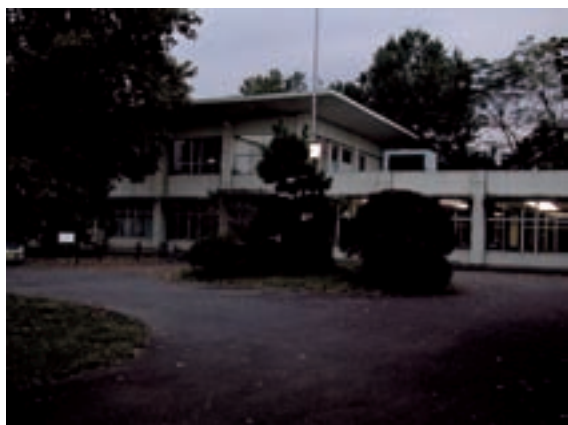
▲那加福祉センター 施工前 平成 16 年撮影
