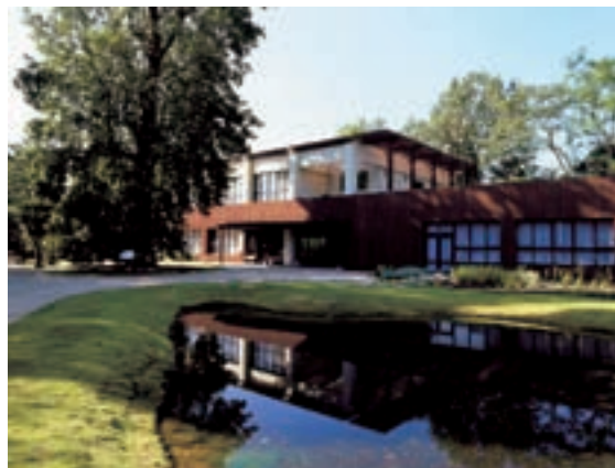
▲那加福祉センター 施工後 平成 17 年撮影
