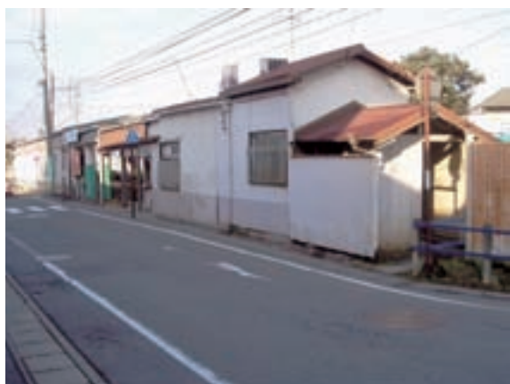
▲各務原市役所前駅 改修前(正面) 平成 19 年撮影
