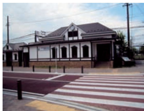
▲各務原市役所前駅 改修後(正面) 平成 20 年撮影
