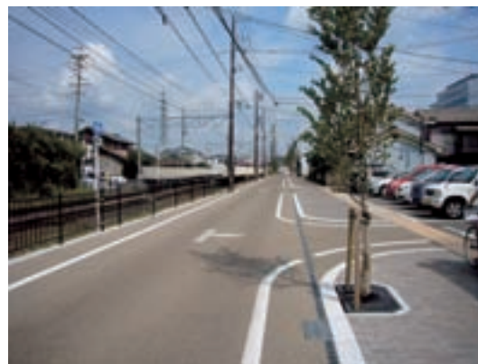
▲産文北通り 施工後 平成 21 年撮影 ※民有地を買収して、歩道付き道路を整備
