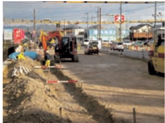
▲(都)岐阜鶴沼線 施工中 平成 21 年撮影
