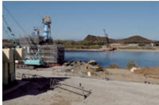
▲(仮)那加小網線 施工中 平成 21 年撮影
