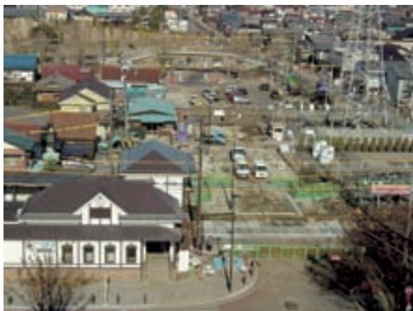
▲樺通り① 施工中 平成 20 年 12 月撮影
