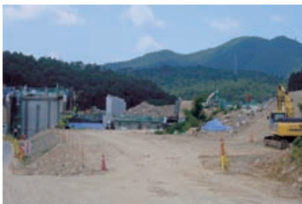
▲(都)坂祝バイパス線 施工中 平成 20 年撮影
