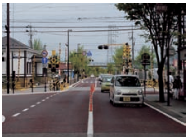
▲樺通り① 完成 平成 21 年 4 月撮影
