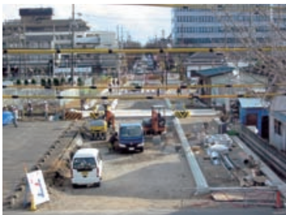
▲樺通り② 施工中 平成 21 年 2 月撮影
