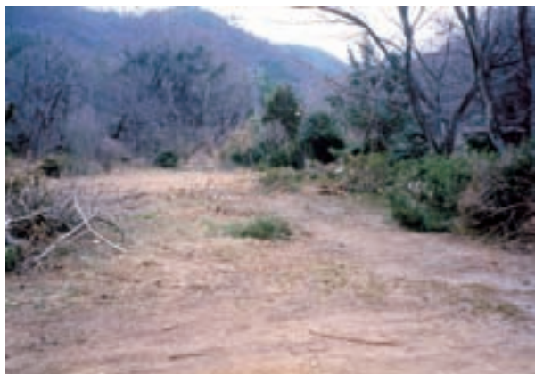
▲各務野自然遺産の森 施工前 平成 11 年頃撮影
