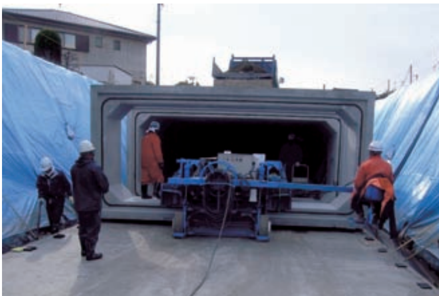
▲上戸雨水幹線築造工事 平成20年撮影
