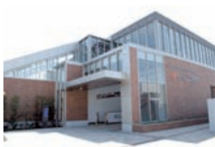
▲鵜沼駅舎(H21.3 橋上化) 平成 21 年撮影
