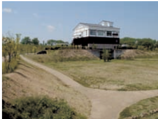
▲上戸排水機場 平成21年撮影
