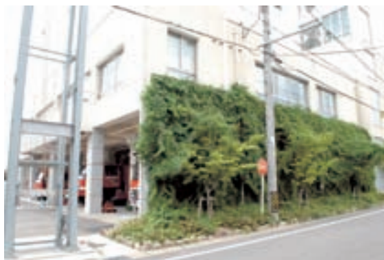
▲建物の壁面緑化の事例 平成 21 年撮影
