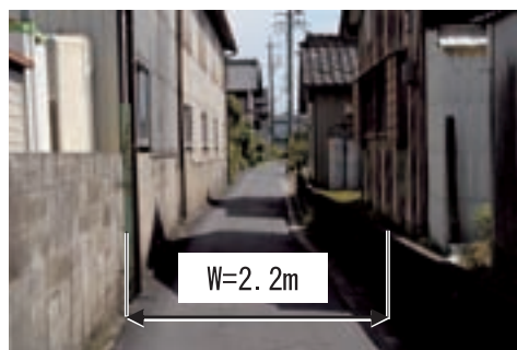
▲狭あい道路(鵜沼南町地内) 平成21年撮影
