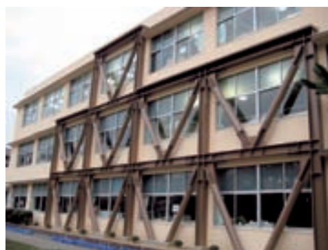
▲建築物耐震化 完成(那加第三小学校) 平成 21 年撮影
