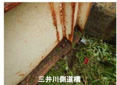
主桁の腐食
