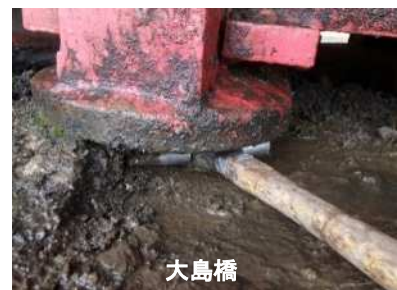
沓座モルタルの欠損
