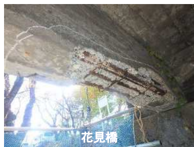
主桁の鉄筋露出
