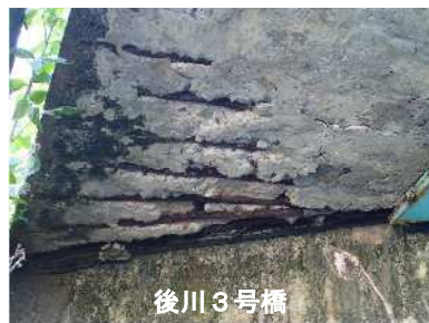
床版の鉄筋露出
