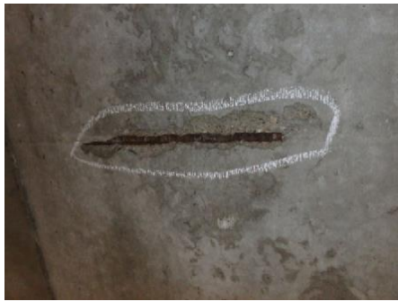
浮きによる鋼材の露出
