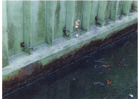
地覆と舗装の境界の腐食
