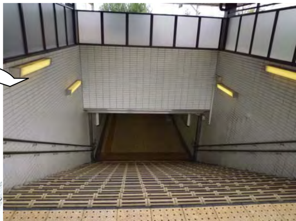
▼エスカレータ・エレベータが設置されていない新那加駅への階段
