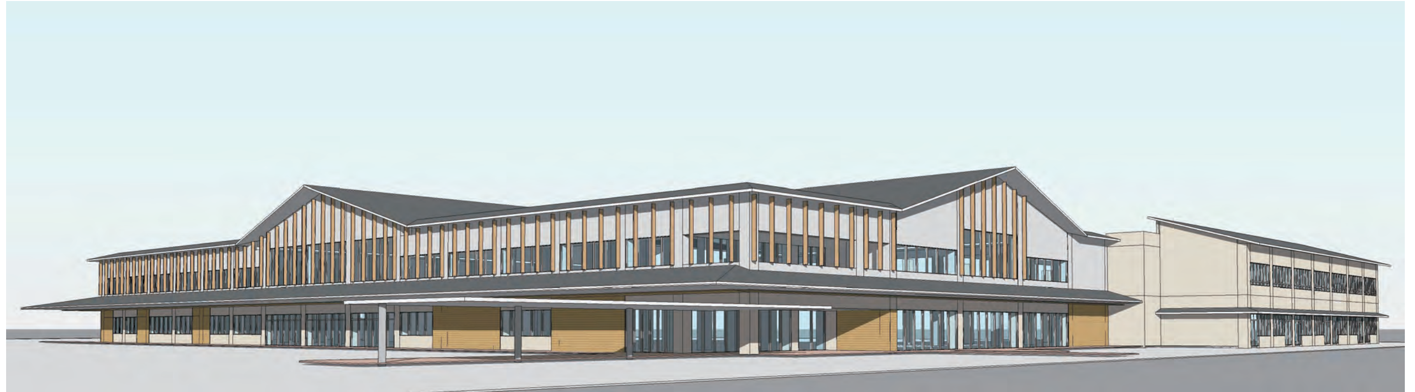
南西から建物を望む
