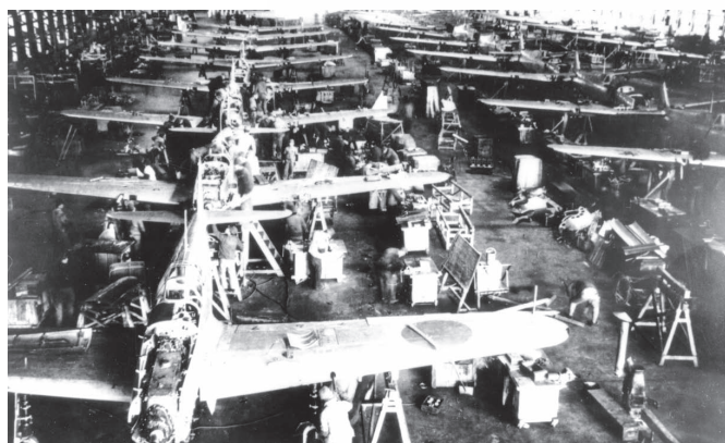
写真2 川崎航空機岐阜工場での飛燕の組立(1944年頃)
