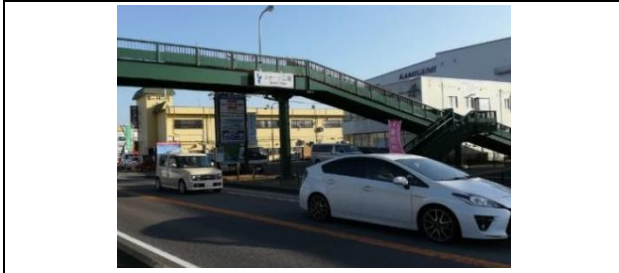
県道 17 号線 南進 (表記は「スポーツ広場」)
