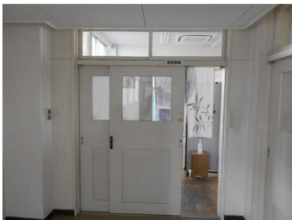
入口／2階 東端 （中が直接見えないような配慮）
