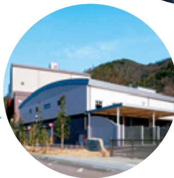
北清掃センター・ リサイクル施設
