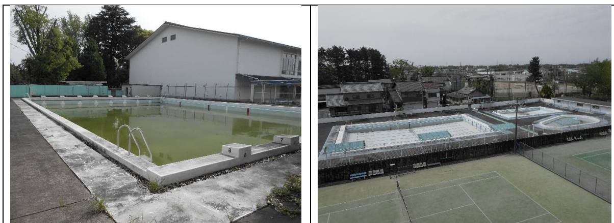
現況写真(左:那加中学校プール、右:川島小中学校プール)
