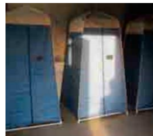
屋内設置のマンホールトイレ
