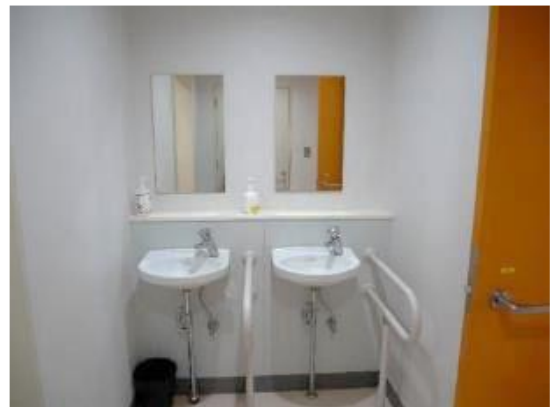
手すりを設置したトイレ (さいたま市与野本町小学校)
