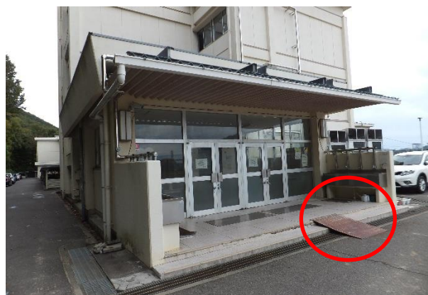
仮設スロープ
