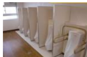
小便器間に仕切り設置
