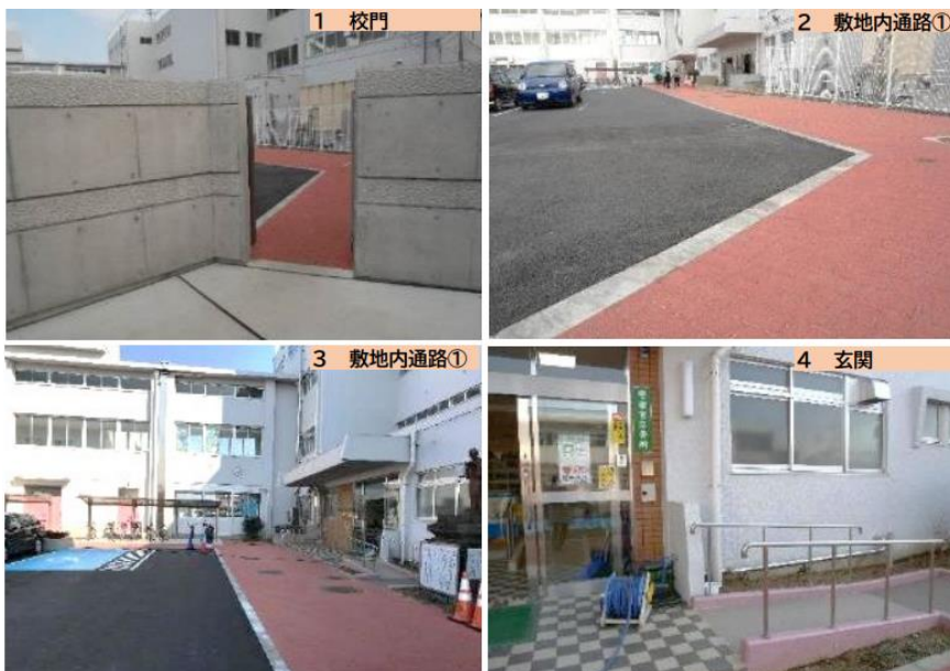
校門から南校舎の玄関までのバリアフリー化された敷地内通路
