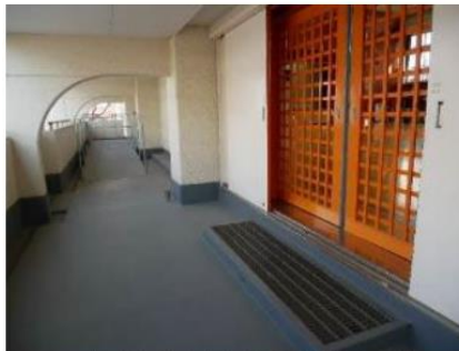
スロープの設置された屋内運動場の出入り口
