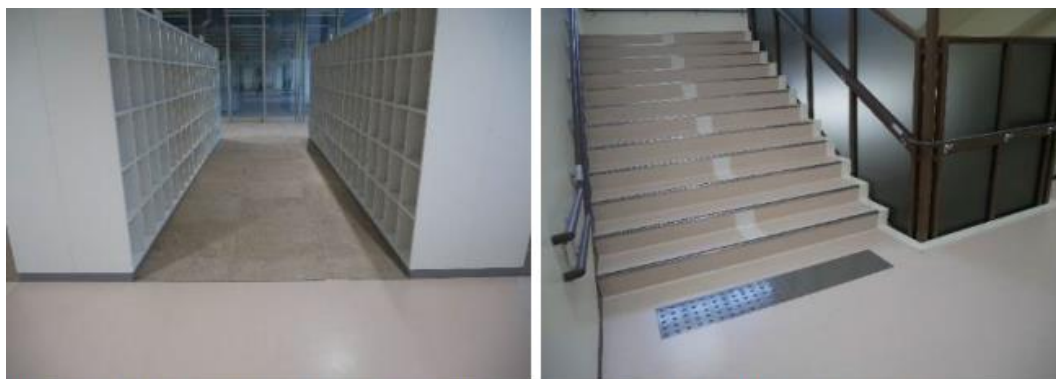
外履き部分と上履き部分で床高を併せた昇降口 点状ブロック、手すりを設けた階段
