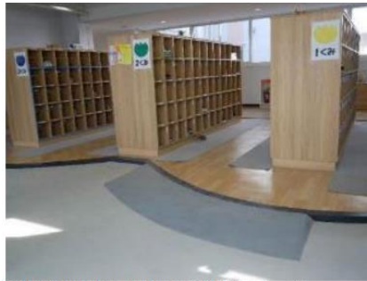
東校舎の昇降口に設置されたスロープ
