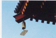
写真20 風招使用例(元興寺) 風招は風路内には舌にぶら下がっていて、風を受けて揺れることで在庭音を奏でます。
