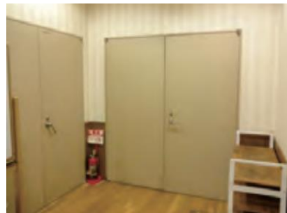
施設内の連絡扉
