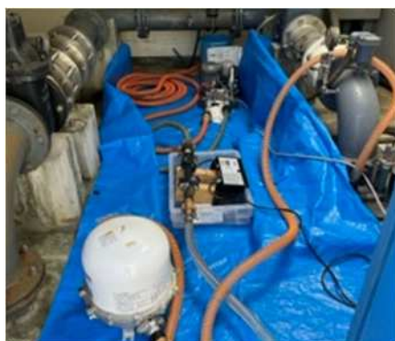
写真 2 試験風景（導水管→試験機通水）
