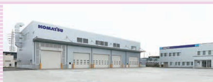
コマツ岐阜オフィス新築工事
