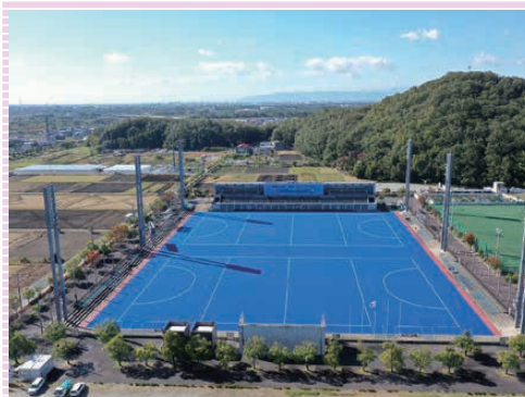
岐阜県グリーンスタジアム人工芝更新工事
