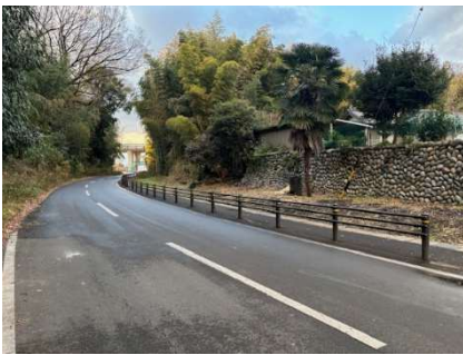
市道川 40 号線整備
