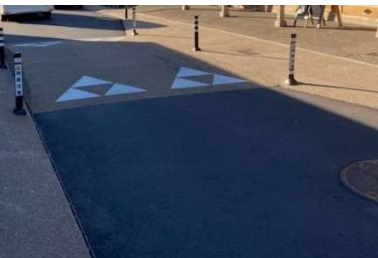
道路沿道整備
