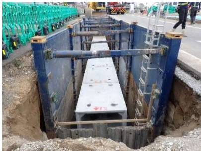
R5 鷺沼古市場 第 3 雨水幹線築造工事写真
