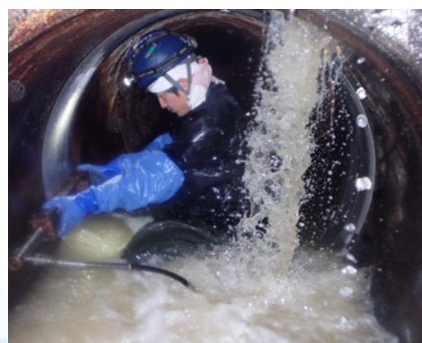
【下水道の耐震化工事の様子】
