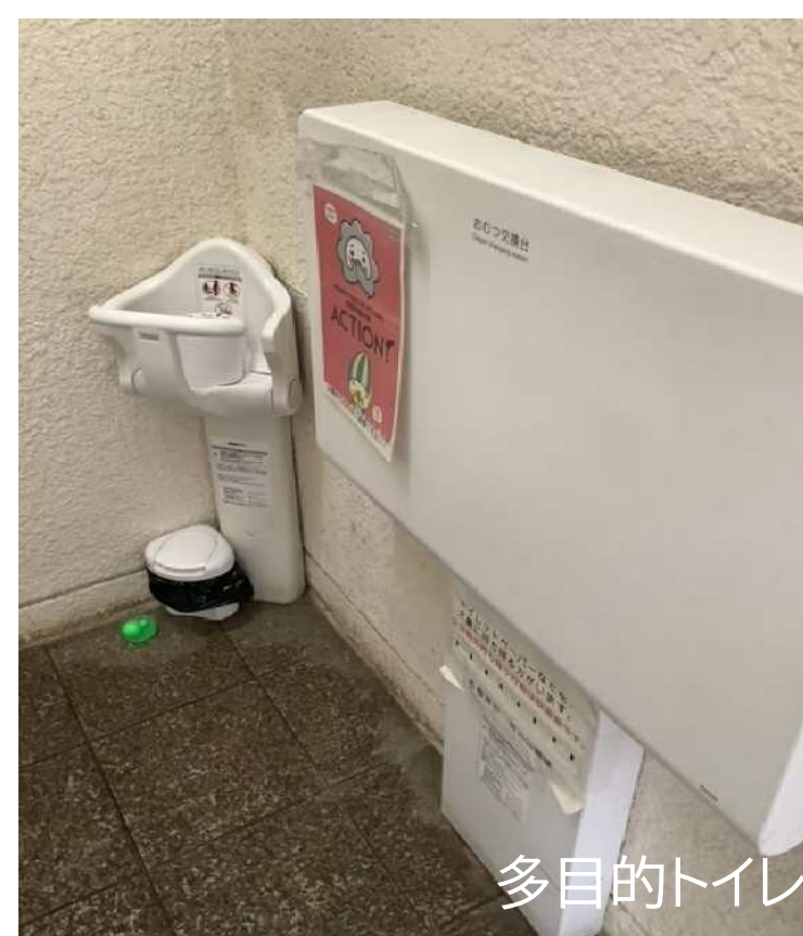
多目的トイレ
