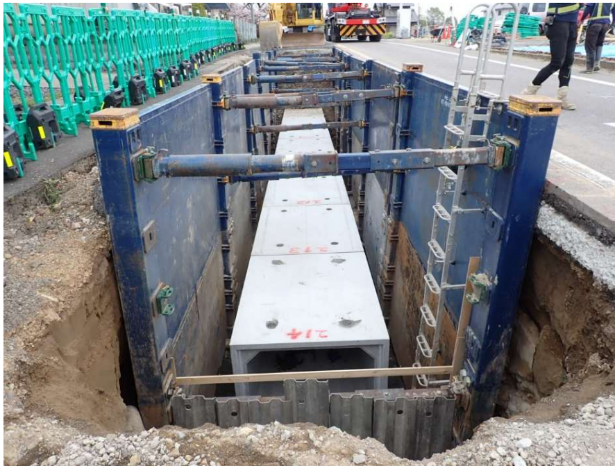
鵜沼古市場第3雨水幹線整備
