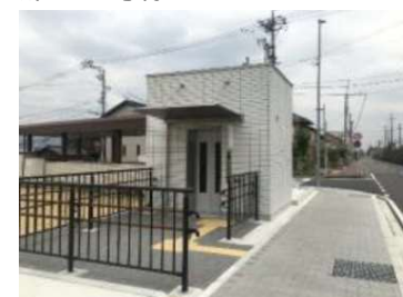
エレベーター設置
