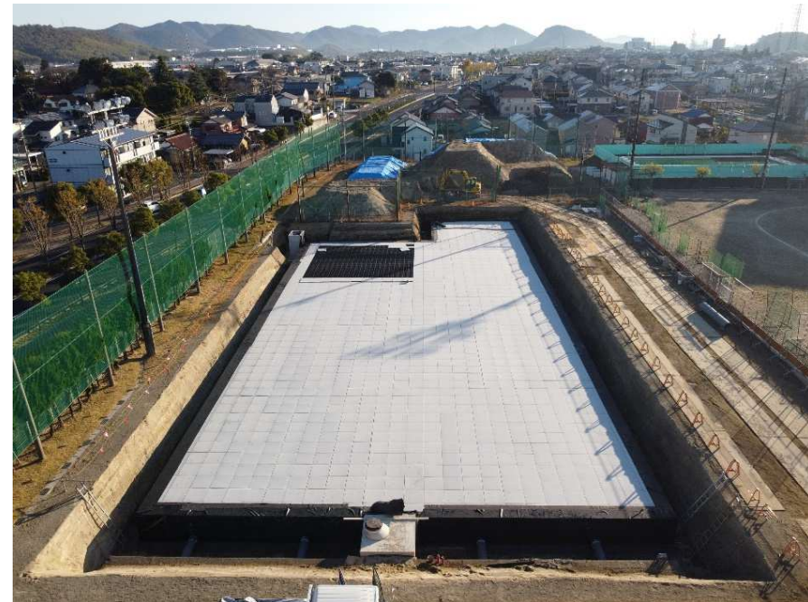
蘇原中貯留施設整備
